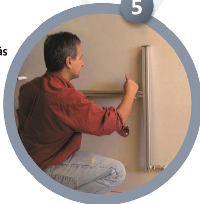
Con la ayuda de útil Nivelador marca soportes le será mucho más fácil colgar radiadores. Consta de una barra vertical que se sujeta al grifo del radiador y actúa de primer elemento, y otra horizontal que se desliza sobre la vertical y lleva incorporado un nivel, ambas llevan métricas de lectura.
