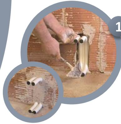
Colocar la curva doble completa en la roza de la pared. Puede ser de ladrillo o de pladur.
